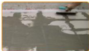
Eseguire la fuga delle piastrelle
