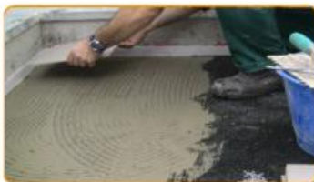
Stendere lo strato di colla sul Sylcer e posare le piastrelle
