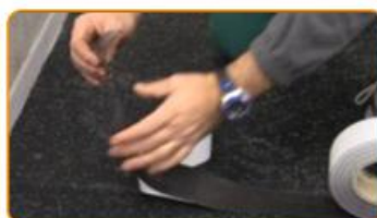
Nastrare con il nastro Stik le giunzioni dei rotoli
